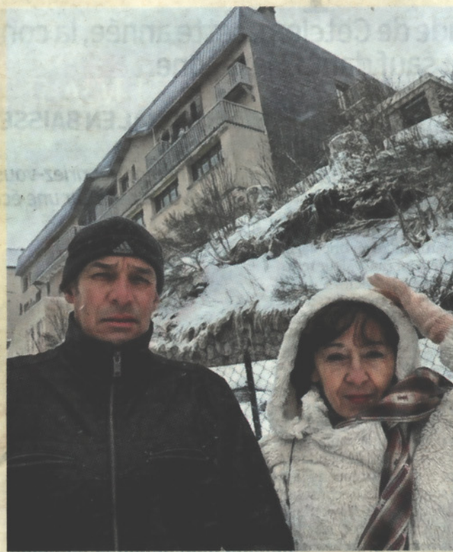
Super Lioran (Cantal), le 27 janvier. François et Josiane Merle ont déjà dépensé plus de 215 000 € pour un T4 qui n'a jamais été construit.
